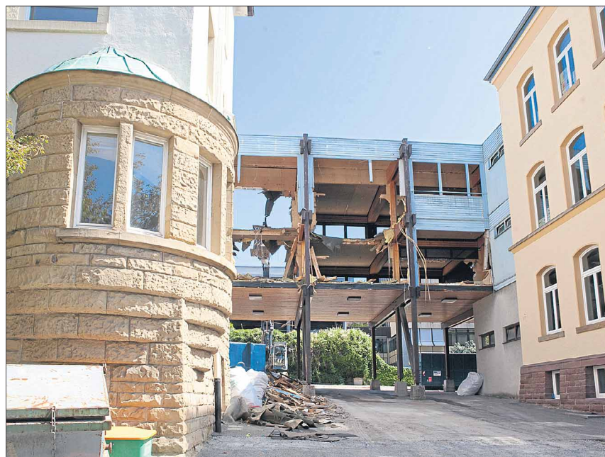
Abbrucharbeiten auf dem Grundschulcampus an der Schulgasse.
